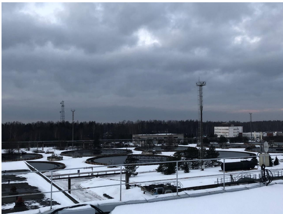
Станция биологической очистки сточных вод Daugavgrīva
