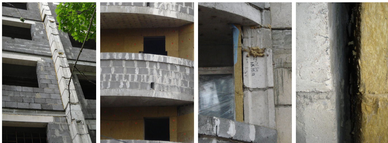
Рисунок 1. Непрерывность теплоизоляции
