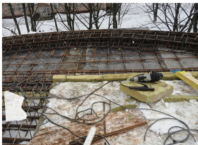
Рисунок 2. Исполнение строительства. Соединительные элементы
