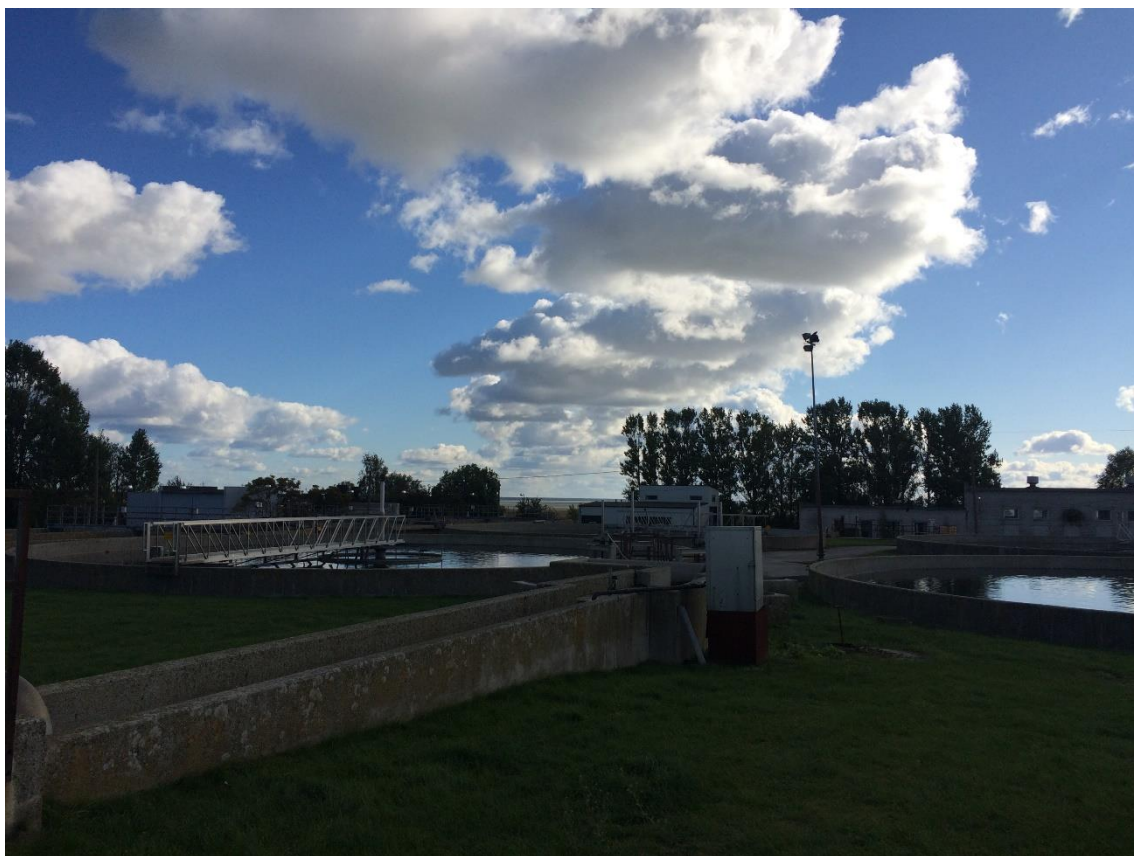
Станция очистки сточных вод г. Пярну «Pärnu Vesi»
