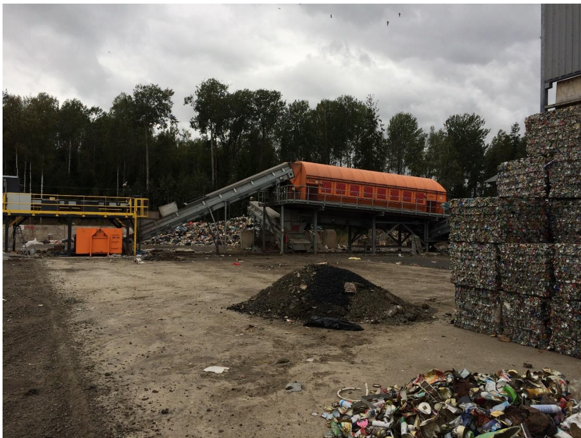
Линия сортировки смешанных отходов на полигоне ТКО г. Пярну
