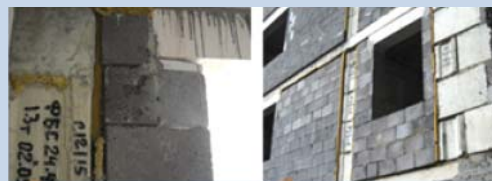
Рисунок 6. Неточное соединение строительных элементов
