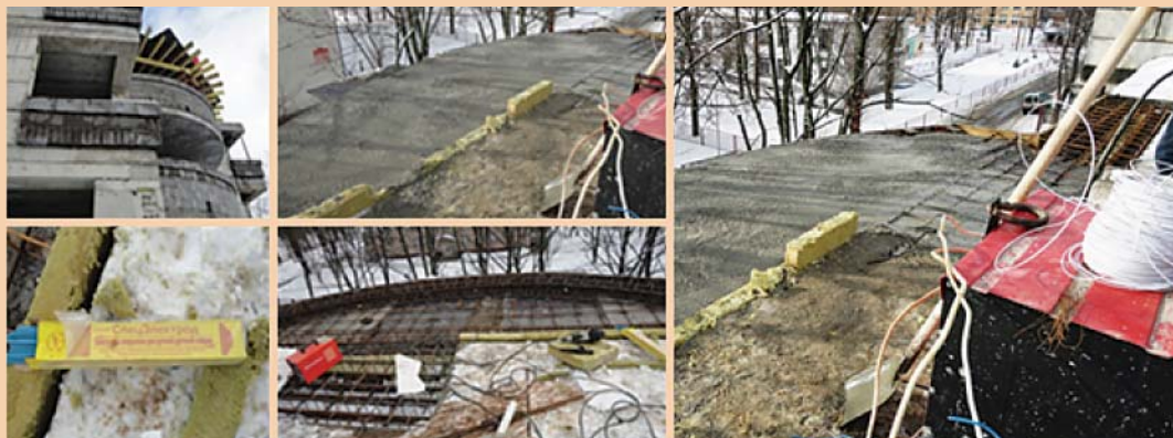
Рисунок 3. Установка изоляции между строительными элементами
